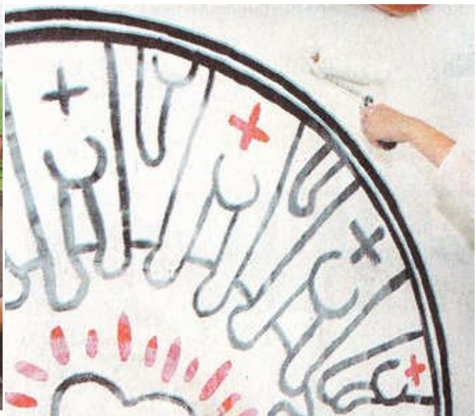
Arbeitseinsatz im Fahrradkeller: Auch Henrik Wittenborn (16) hilft mit. Weiße Farbe hat jetzt das unansehnliche Grau der vergangenen Jahrzehnte ersetzt.
